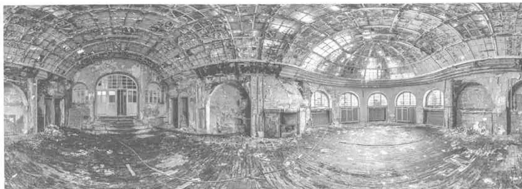
Lesesaal, Panoramaaufnahme des Zustandes vor der Sanierung
