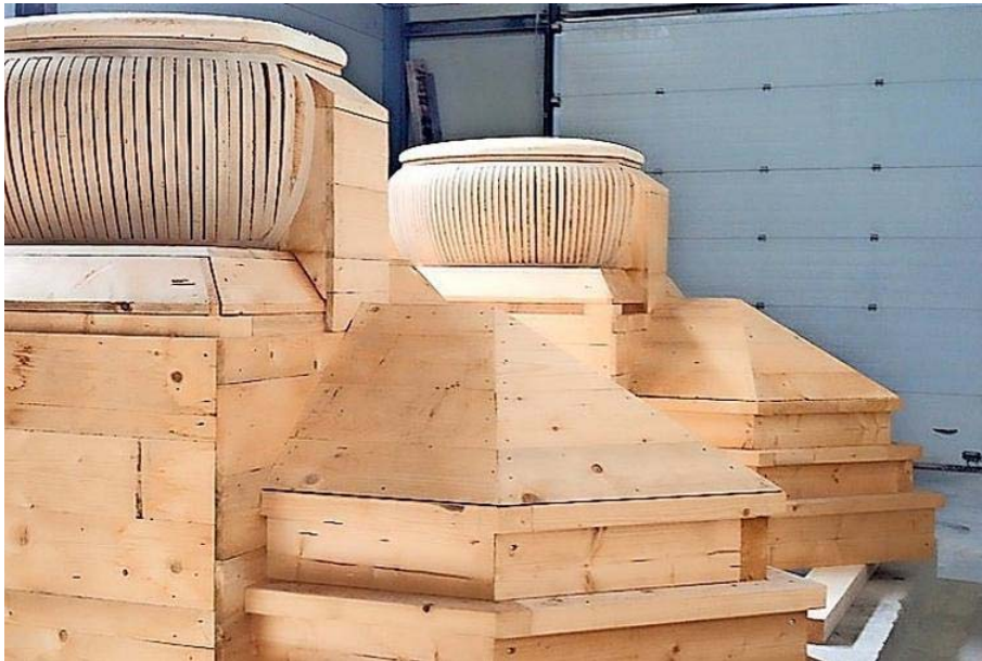
So schauten die Turmhauben für das Palais Weißer Hirsch während ihrer Entstehung aus. Sie bestehen aus einem hölzernen Unterbau und der Verblechung darauf. Am Mittwoch werden sie aufgesetzt. Quelle: Hildebrandt Architekten
